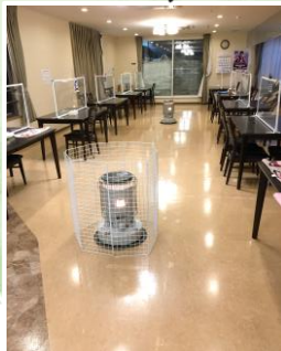
エアコン故障により ストーブ出動
